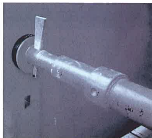
切梁とパネルの一体化
