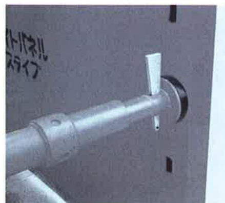
コッター（くさび）が鉛直で一体化
